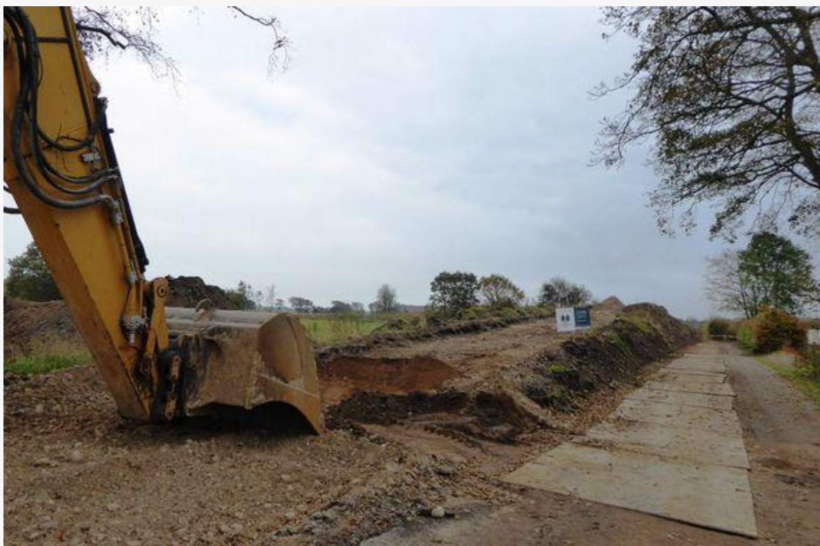
Natten mellem den 23. og 24. oktober 2015 - - blev den gamle bro, der forbandt Estrupvej med Esbjergvej , nedrevet.
