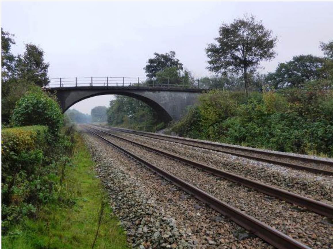
Jernbanelinien mod øst ved den gamle bro set fra ledvogterhuset. Der er intet årstal at se på broen.
