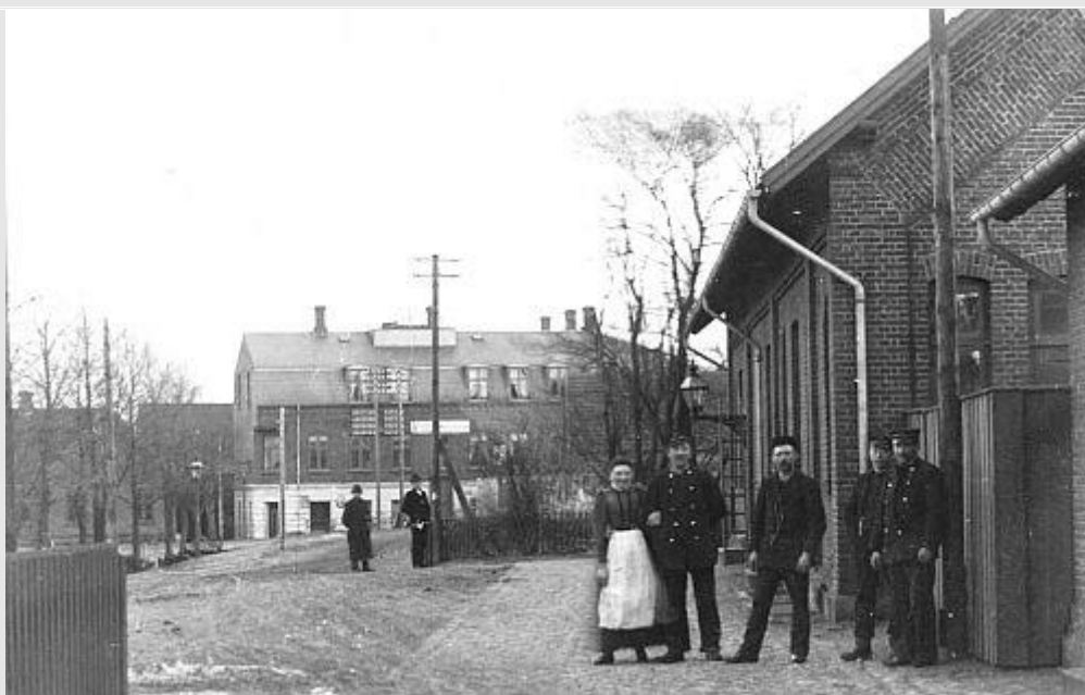
Vejen gamle stationsbygning o. 1905 . Det er Højskolehjemmet , der ses i baggrunden.
