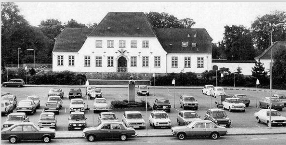
En overgang var skorstenene fjernet fra stationsbygningen. Men det så for forkert ud, og de blev sat på igen. Fotografiet er udateret, men kunne bilerne antyde noget med sidst i 1970'erne !
